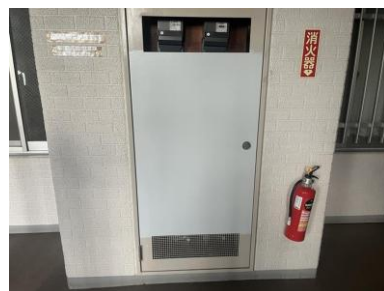
③ 鉄部塗装：施工後
