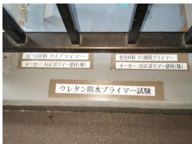
⑤ ウレタン防水プライマー試験
