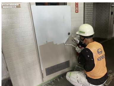
② 鉄部塗装：施工中（下塗り）
